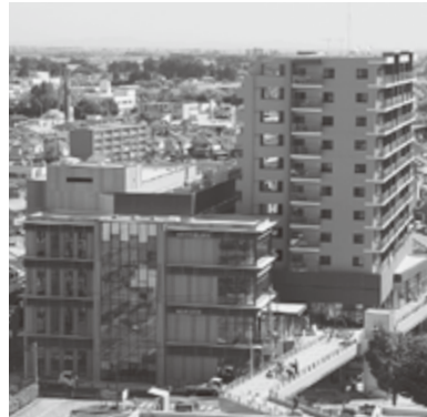
名取駅前建設が進む複合ビル
