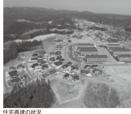
住宅再建の状況
