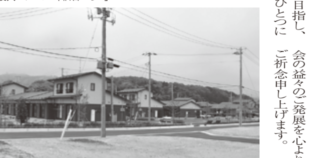
着々と工事が進む新市街地
