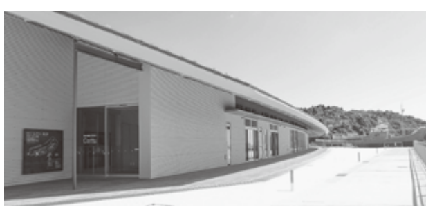
牡鹿地区拠点エリア「ホエールタウンおしか」にオープンした観光物産交流施設
