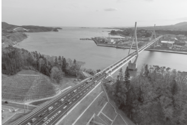
「気仙沼湾横断橋」(かなえおはし) ※仙台河川国道事務所提供
