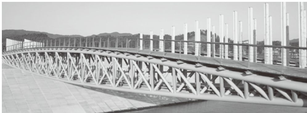
記念公園と志津川市街地を繋ぐ「中橋」
